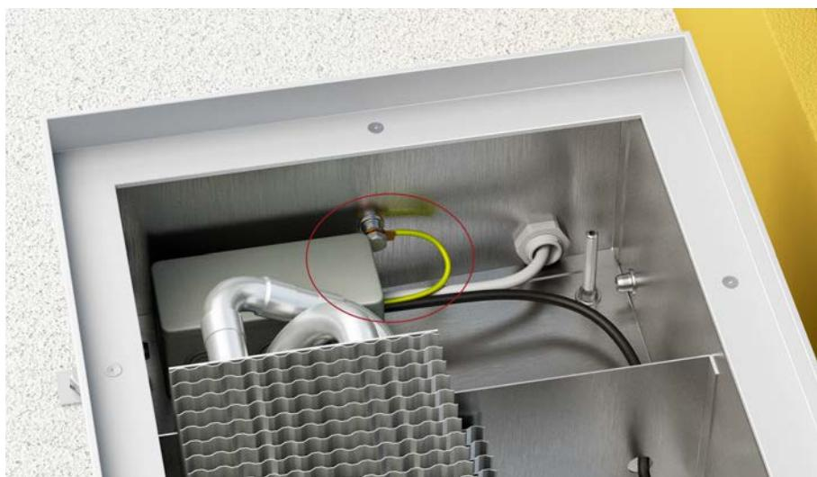
8. Произвести подключение вентилятора (поз. 9) в зависимости от выбранной схемы регулирования тепловой мощности;
